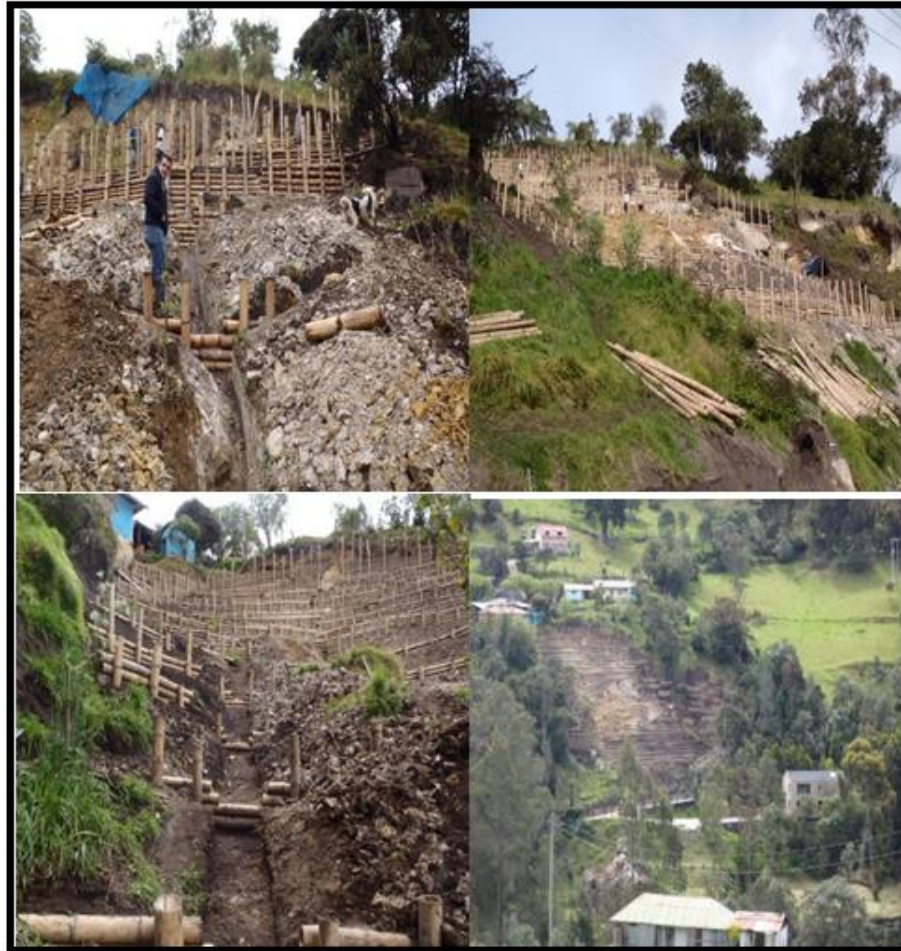
Figura 33. Inicio de trinchos y filtros vivos desde la corona del proceso. Panorámica, Filtro principal y Panorámica de la obra (15 de julio, 9, 13 y 26 de agosto 2013).
