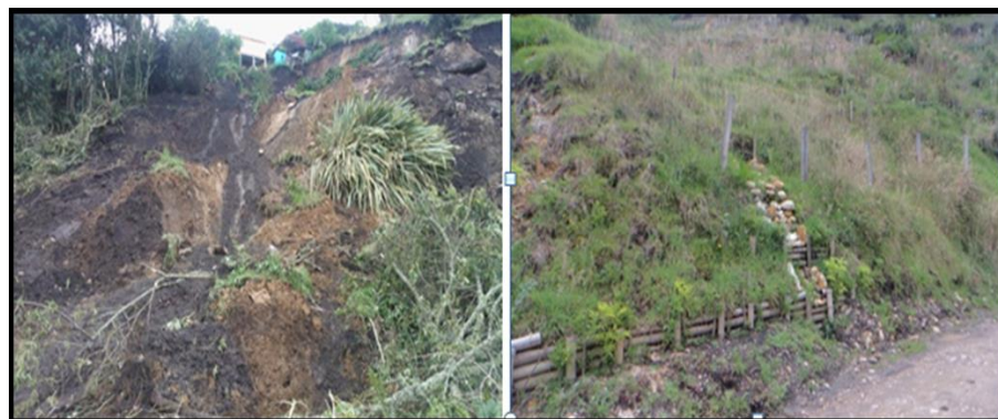
Figura 31. Deslizamiento planar – flujo de tierra (20 de octubre de 2012).. Solución bioingenieril con BFV, TVEVA y TVL (14 de diciembre de 2014). Fotografías: Jhon Alexis Serrato. Luz Elena Franco García. Vereda el Libano Municipio de la Calera.
