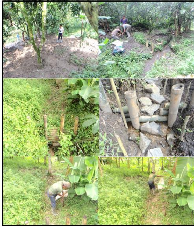
Figura 41. Filtros laterales con drenaje hacia la vía y la quebrada. Filtro cubierto con arvenses y estacas de nacedero a cada lado del mismo (Trichanthera gigantea). Diciembre 2014. Fotografías: Alejandra Osorio.
