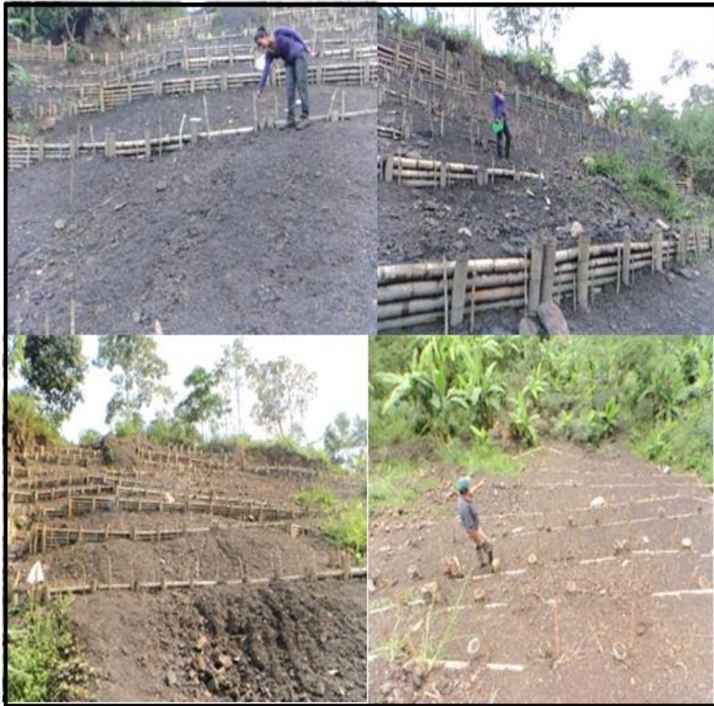
Figura 40. Trincho con vegetación. Estacas de nacedero con rebrotes de hojas. Trinchos con suelo desnudo y estacas vivas sin brotes. Diciembre de 2014. Fotografías: Fernando Sánchez.
