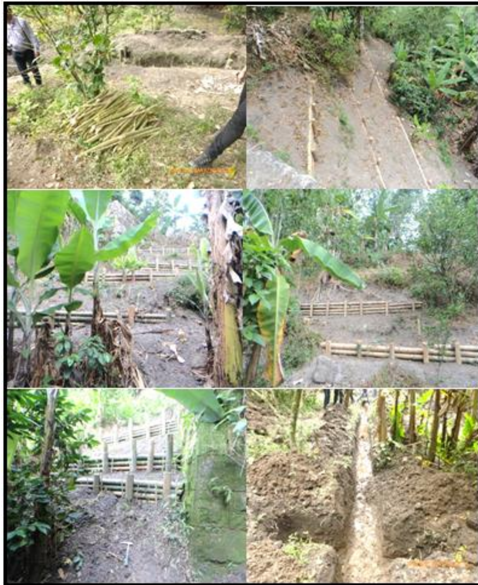
Figura 39. Trinchos sin prendimiento de estacas vivas. Filtros vivos y estacas vivas de nacedero. Filtros en construcción y en funcionamiento. Abril de 2014. Fotografías: Alejandra Osorio.
