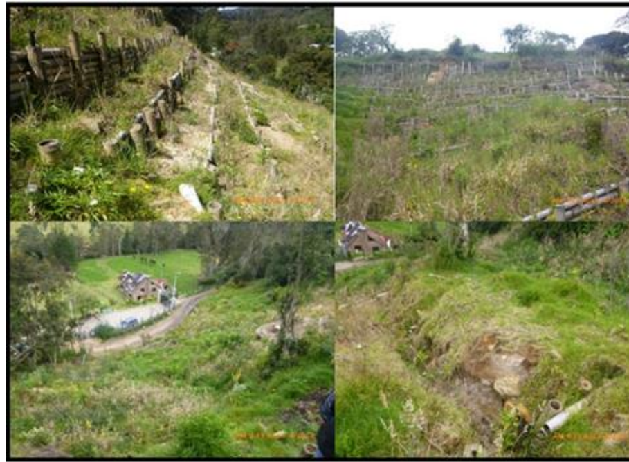
Figura 35. Panorámica de la obra. Sucesión natural y trinchos sin sauco en la parte alta. Agosto de 2014. Fotografías: Alejandra Osorio.
