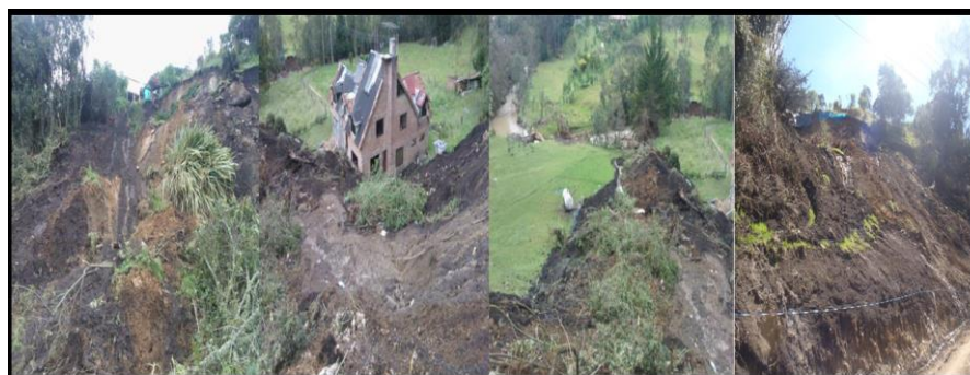
Figura 32. Corona, cuerpo, base y material removido por el proceso denudativo en la vía terciaria el día 21 de noviembre de 2012.
